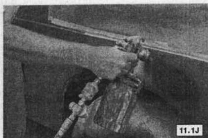
10 Нанесите несколько слоев грунтовки на обрабатываемую поверхность. Не разбрызгивайте слишком много грунтовки, чтобы она не стекала, и после нанесения каждого слоя давайте предыдущему высохнуть. Обычно здесь используется профессиональный пистолет-разбрызгиватель, но в магазинах автозапчастей имеется в продаже грунтовка в недорогой аэрозольной упаковке
